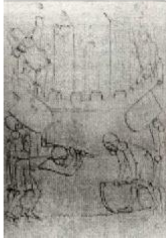
Рис. 84. Разрушение стены кирками.
