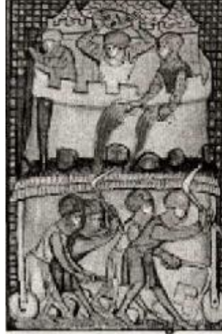
Рис. 85. Разрушение стены под прикрытием черепахи
