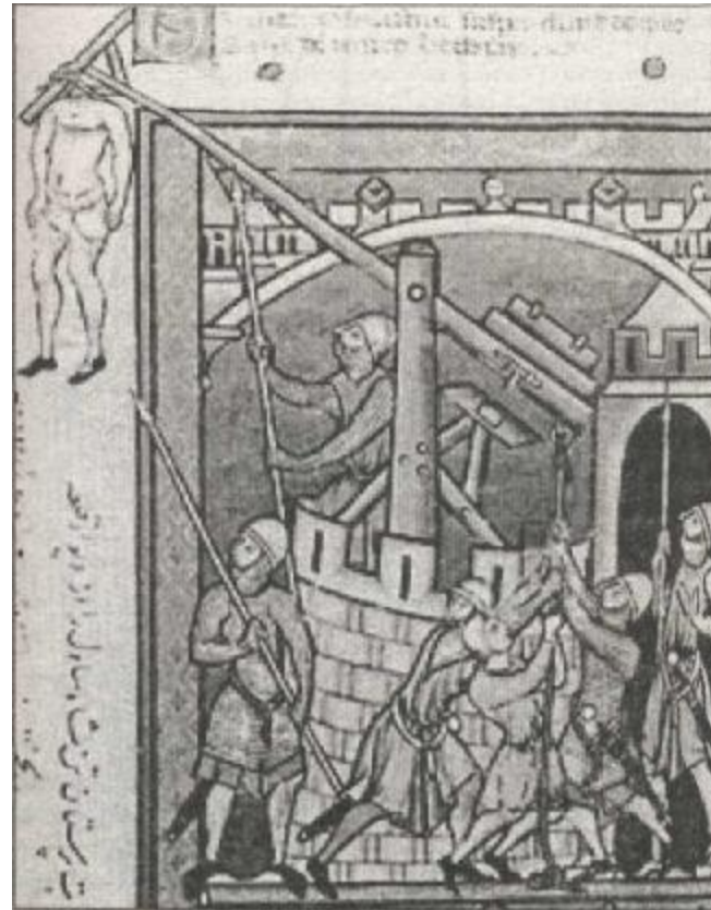
Рис. 166. Наиболее подробный рисунок военного крана. Из «Библии Мацейовского» (около 1240 г.). Подобные краны широко использовались во времена Античности и Средневековья для сбрасывания различных тяжелых предметов на осадную технику осаждающих. В данном случае художник изобразил вывешенное на кране тело царя Израиля Саула (царств. 1021 — 1000 гг. до н.э.), хотя вооружение воинов и прочие детали являются характерными для Средневековья
